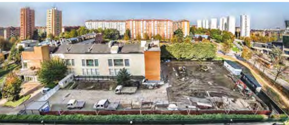
Ottobre 2016, inizio lavori
